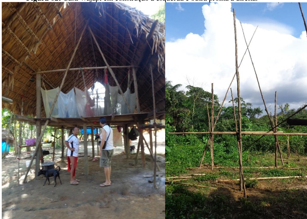
Figura 02: Casa Wajãpi em construção à esquerda e outra pronta à direita.
