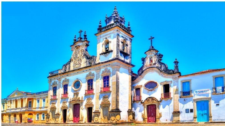
Figura 5: Fachada da Igreja de Nossa Senhora do Carmo (visão lateral)
