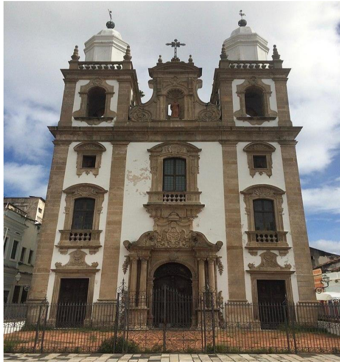
Figura 2- Fachada da Igreja.
