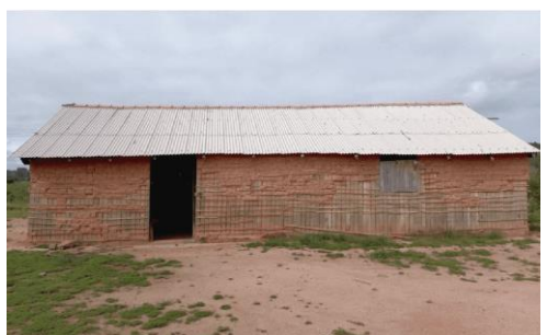
Figuras 12 e 13: Edificação em Madeira com Taipa de Sopapo.
