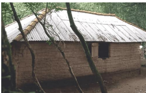
Figuras 10 e 11: Edificação em Pau-a-pique com Taipa de Sopapo.
