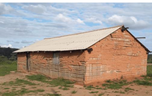
Figuras 12 e 13: Edificação em Madeira com Taipa de Sopapo.
