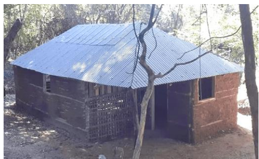
Figuras 10 e 11: Edificação em Pau-a-pique com Taipa de Sopapo.
