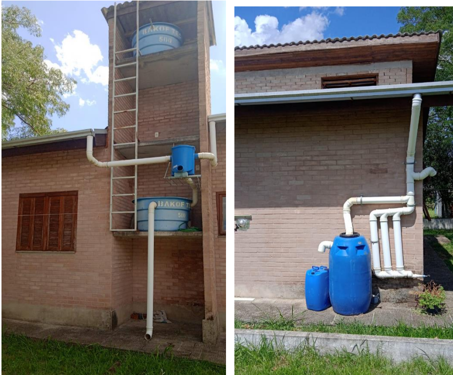
Figura 6: A) Detalhamento da captação de água pluvial armazenada no reservatório inferior. B) Armazenamento da água para uso externo.
