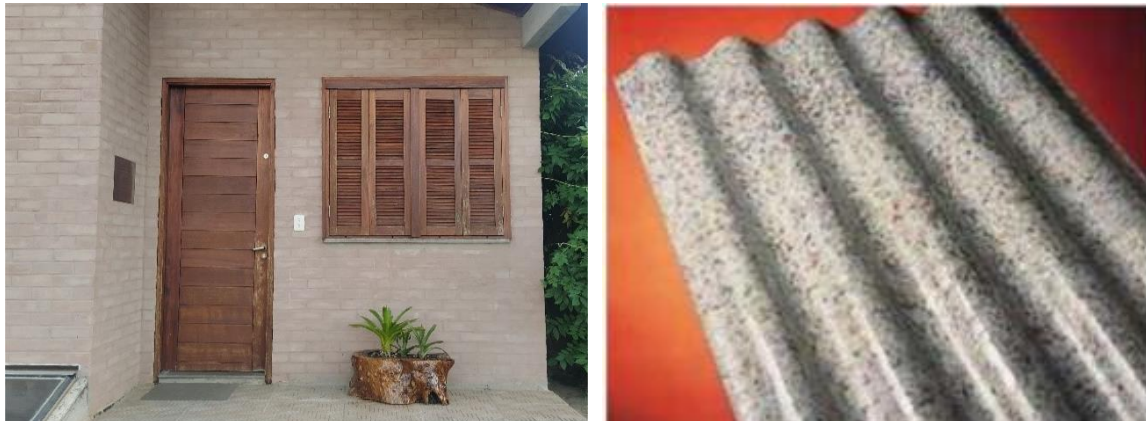
Figura 10: A) Esquadrias na entrada da Casa Popular Eficiente. B) Modelo da telha ondulada tetra pak usada na residência.
