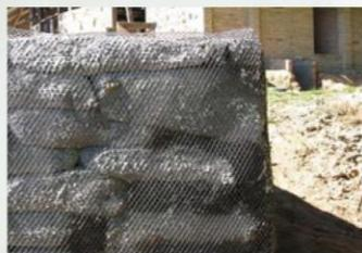
.2º - Envolver a estrutura com uma tela de pinteiro para facilitar o reboco e proteger a estrutura.
