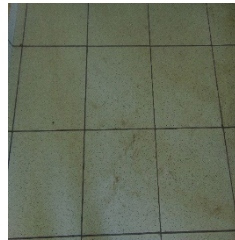
Figura 5: Revestimento do piso. Fonte: SILVA e BRASIL, 2019.
