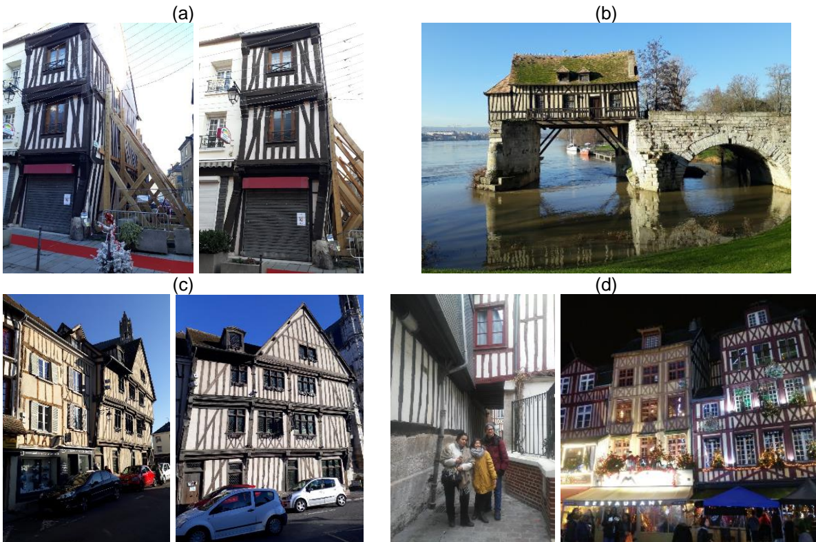
Figura 7: Construções em enxaimel na França: (a) e (b) edificação em Giverny; (c) e (d) edificação em Rouen.
