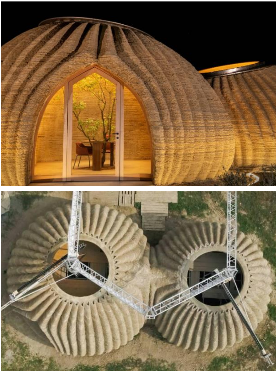
Figura 1: Casas inspiradas em abelhas impressas com mega impressora à base de terra
