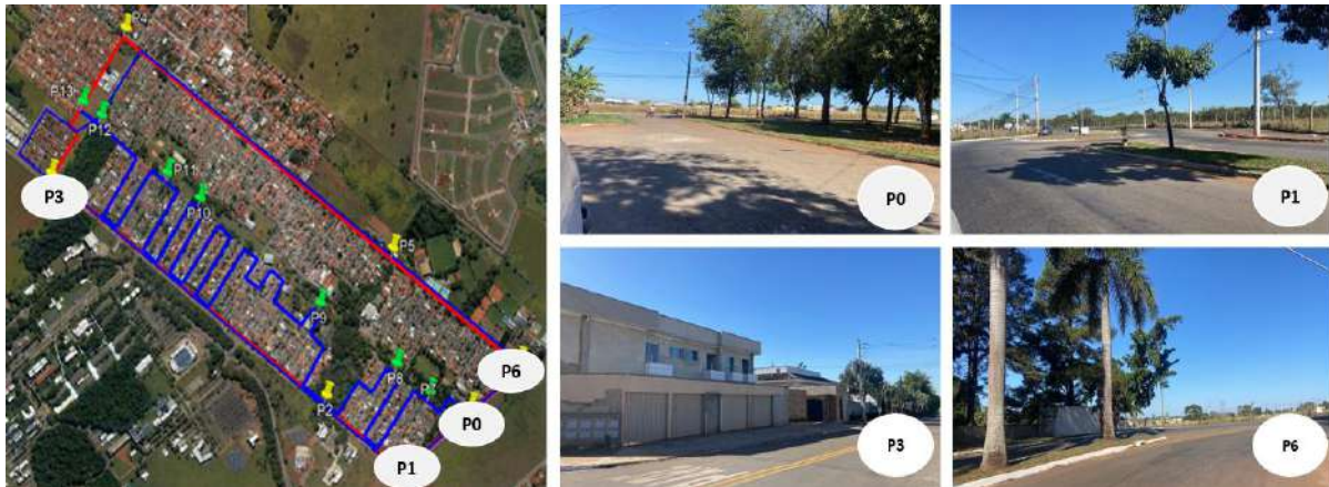
Figura 8: Pontos com asfalto e sem permeabilidade do solo
