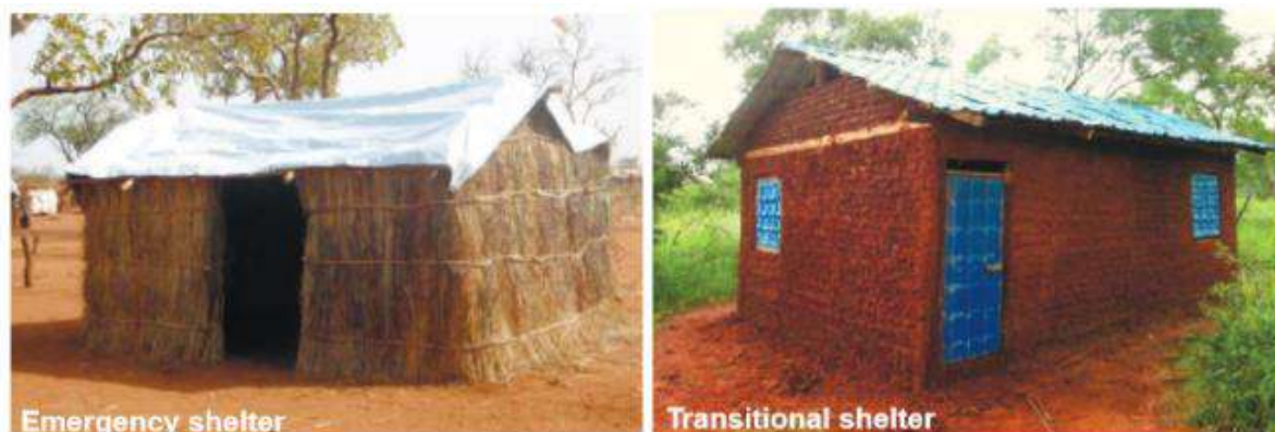
Fonte - Plataforma Infrashelter (VIRTUHAB, 2023).
