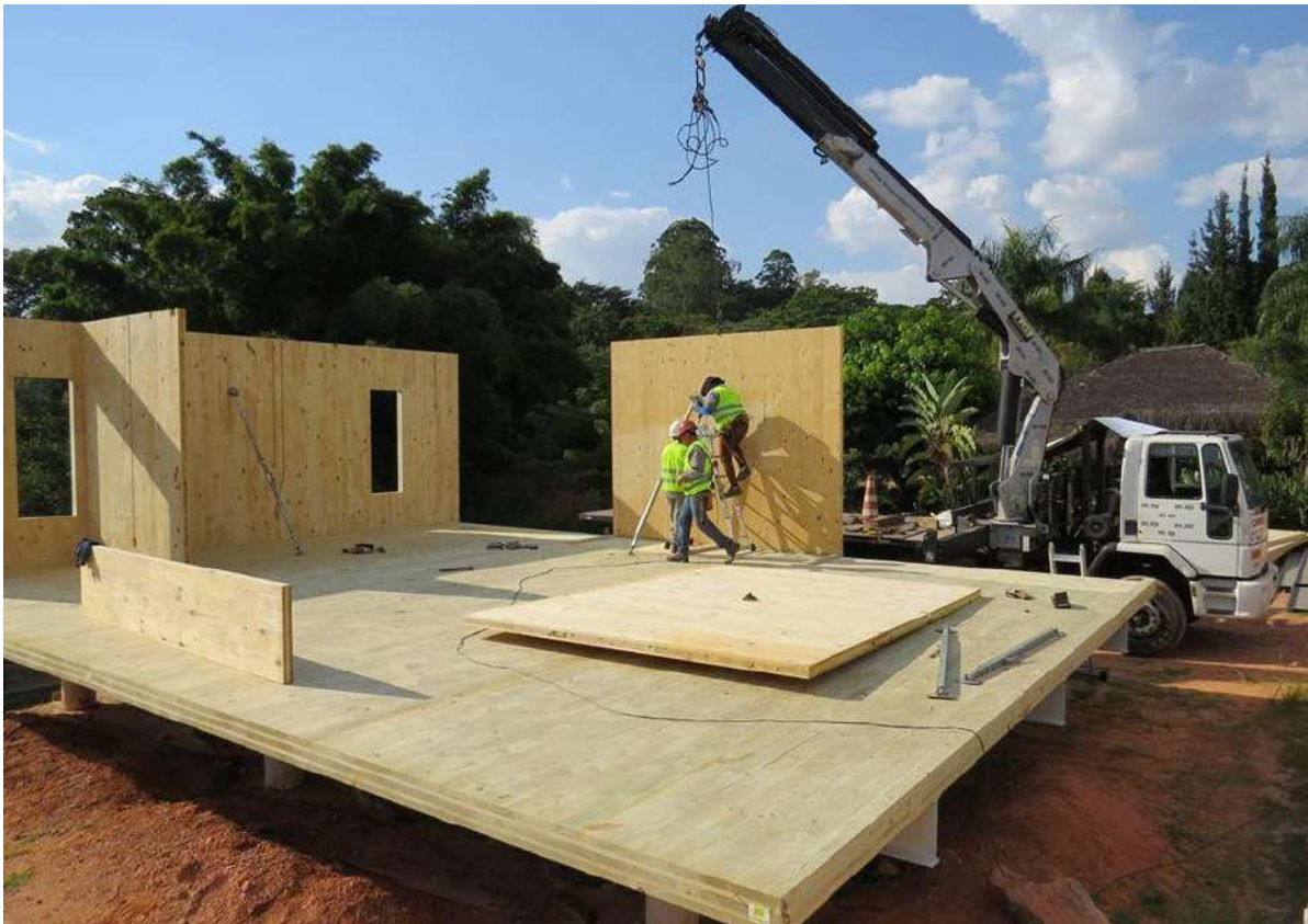
Figura 2: Montagem de paredes com placas de CLT.
