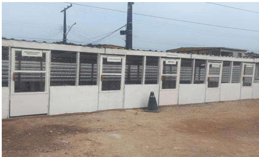
Figura 4: Cabines de armazenamento individuais dos resíduos.
