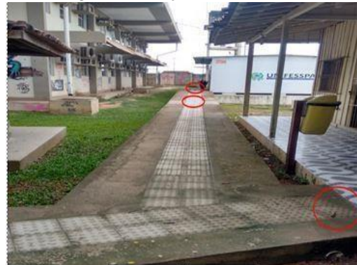
figura 5: Calçada da unidade II
