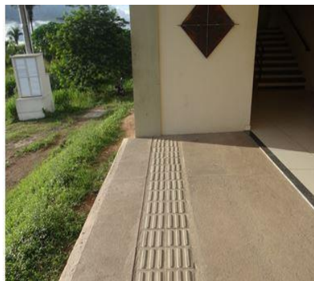
Figura 6: Calçada do Prédio do ILLA unidade III
